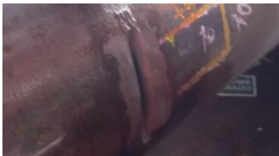
Figura 6 – Abertura do reparo.
