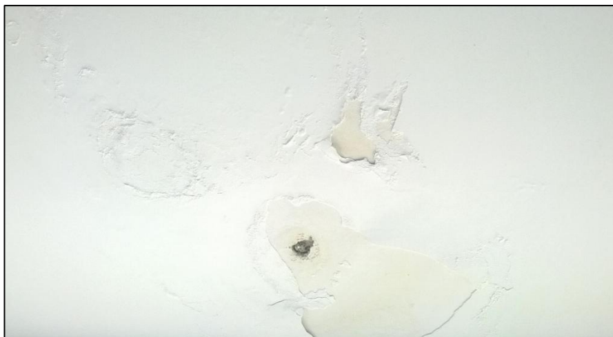
Figura 2- Cobertura de um dos apartamentos visitados
