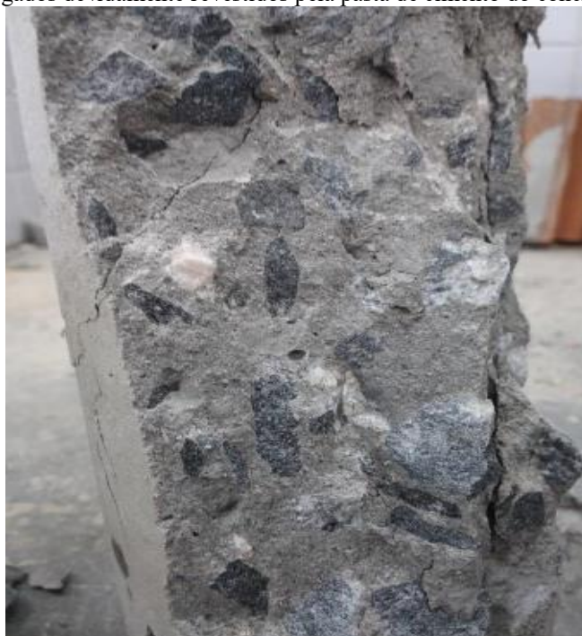
Figura 6 – Agregados devidamente revestidos pela pasta de cimento do concreto convencional
